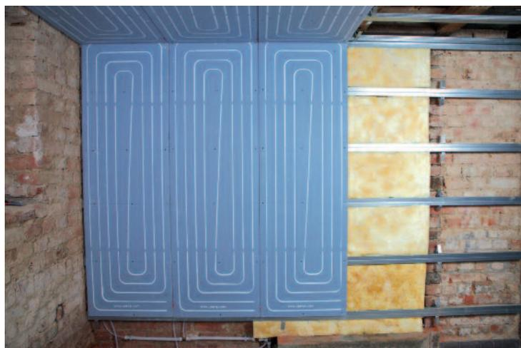
Saubere Installationsart: Das System wird trocken – ohne Nässeeintrag durch Gips und Mörtel – auf dem vorhandenen Untergrund montiert.
