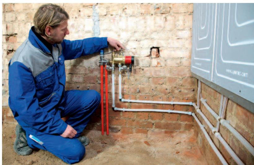
Neben den Renovis Panels kommen alle Komponenten, wie die Ringleitungen aus PE-Xa-Rohr, die Fittings mit Quick & Easy-Technologie, die Pumpengruppe und die Verteiler, oder die Funk-Regelmodule und Funk-Raumfühler alle von einem Hersteller.
