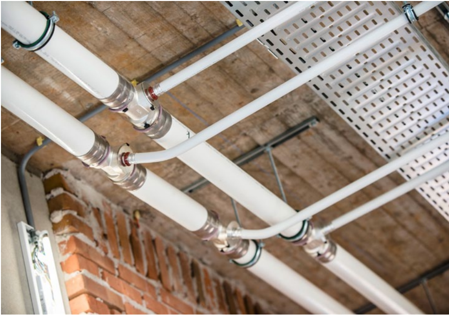
Kleinere Richtungsänderungen, wie das Verspringen über oder unter einer Rohrleitung, können mit Uni Pipe Plus ohne großen Aufwand realisiert werden.
